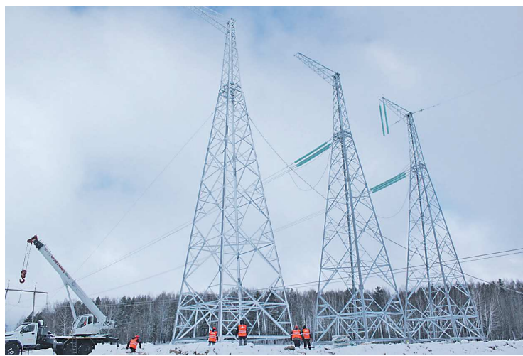
Установка опор на магистральной ЛЭП
