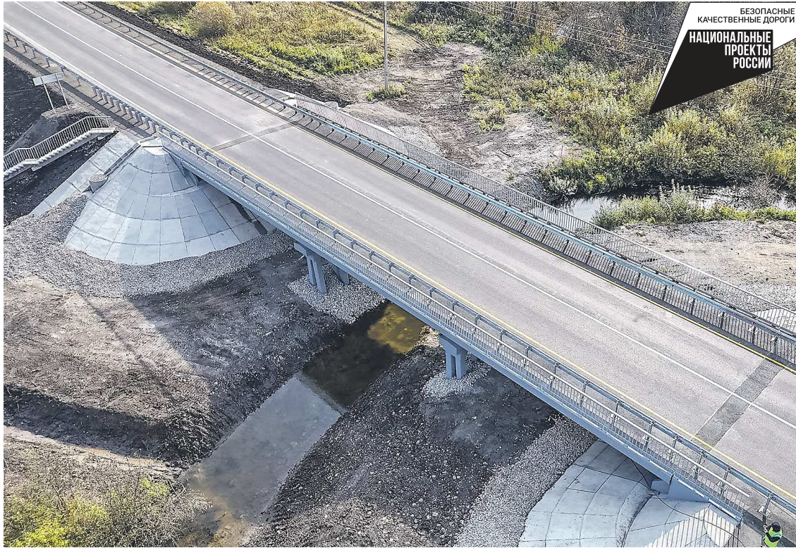
Новый мост отвечает всем современным техническим требованиям
