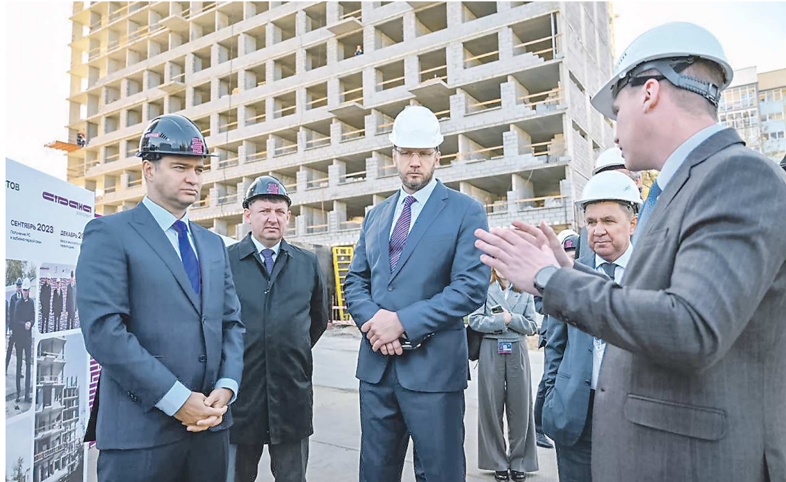
Строительный объект в границах улиц Шефская – Энтузиастов – Баумана – один из первых в России проектов комплексного развития территории. Первый замминистра строительства РФ Александр Ломакин ход работ оценил положительно
