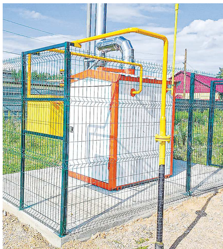
Летний период свердловские муниципалитеты использовали для ремонта старых и запуска новых коммунальных объектов
