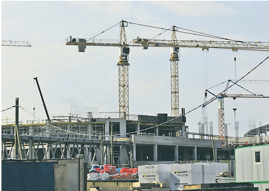
Уже скоро строители начнут монтаж внутренних инженерных систем
