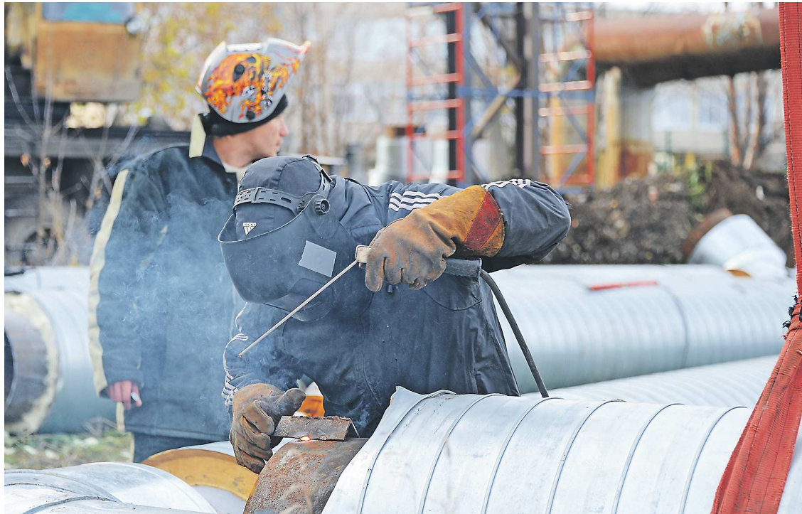
Все запланированные ремонтные работы находятся на завершающей стадии, их проведение не препятствует подаче тепла потребителям
