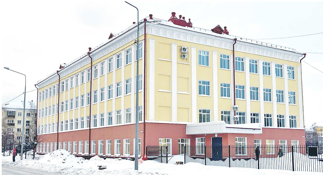
Здание школы №32 было построено в 1936 году. Капитальный ремонт не проводился до прошлого года
