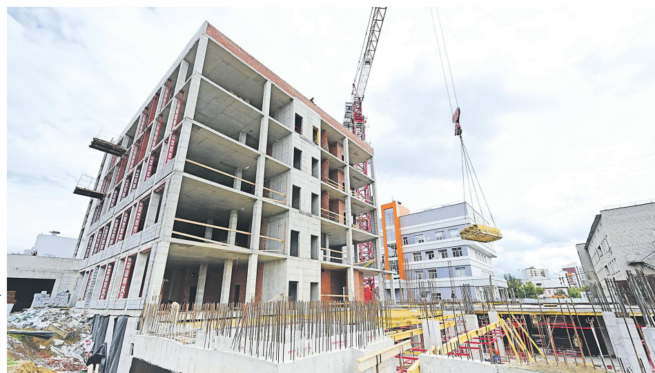
Каркасы двух пятиэтажных блоков уже закончены, сейчас рабочие возводят третий – двухэтажный
