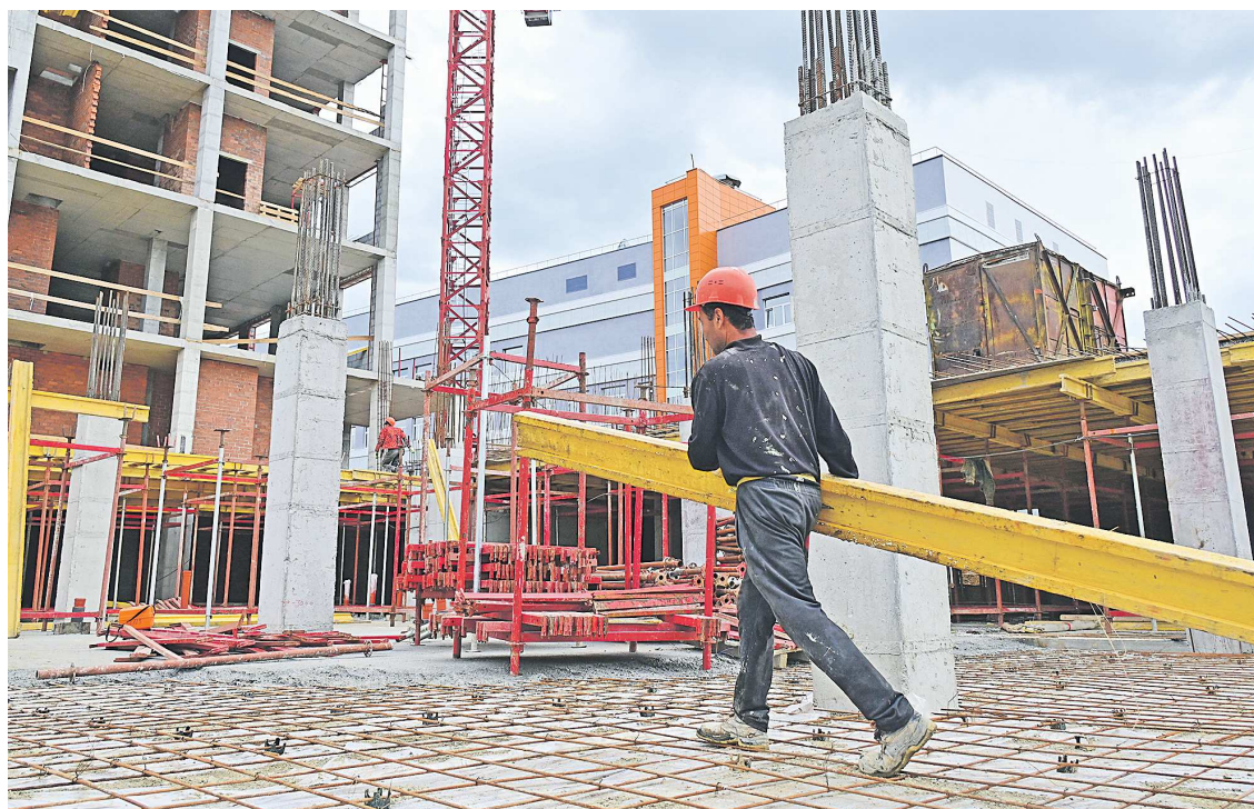
Перед тем, как заливать бетонные перекрытия, рабочие сооружают опалубку
