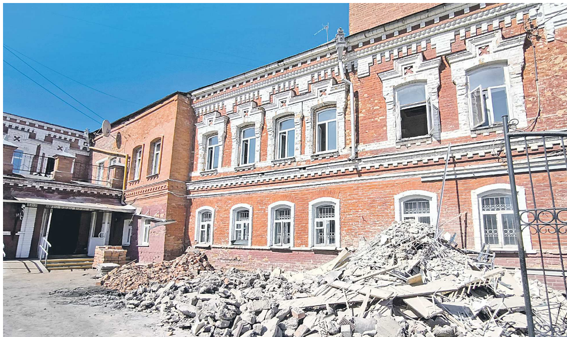
Долгожданный ремонт в здании Ирбитской художественной школы начался в апреле текущего года
