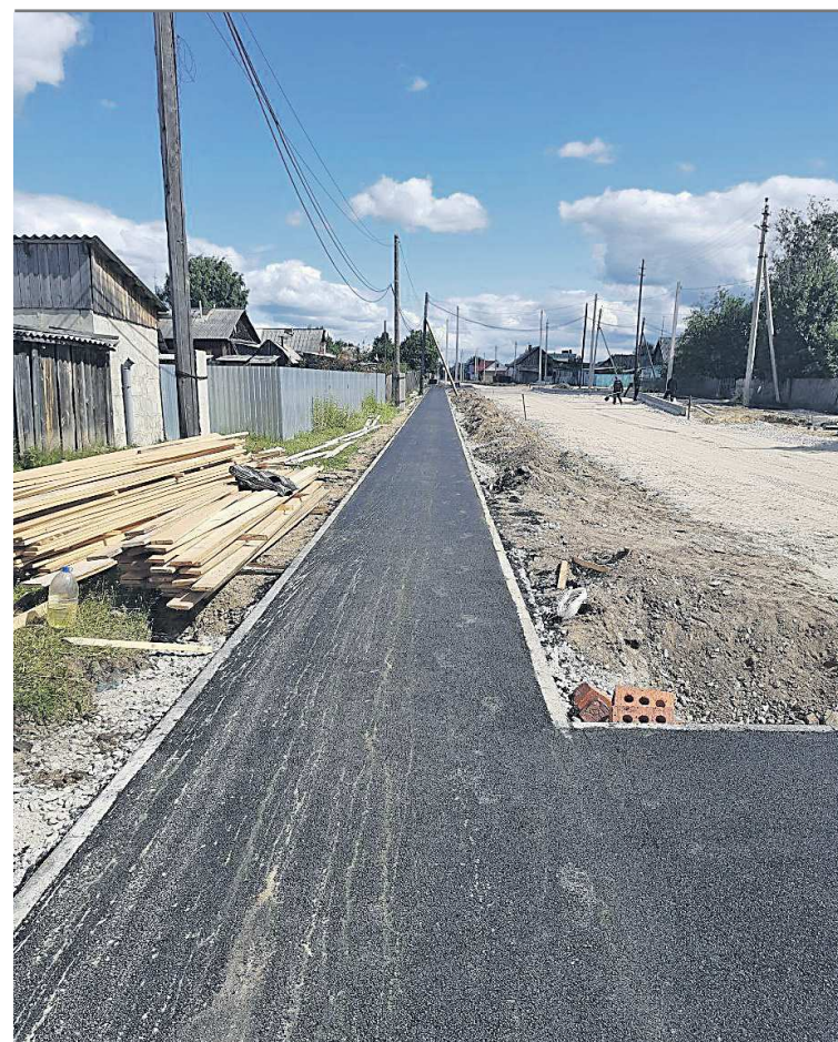
В рамках реализации проекта уже полностью завершены работы по асфальтированию тротуаров
