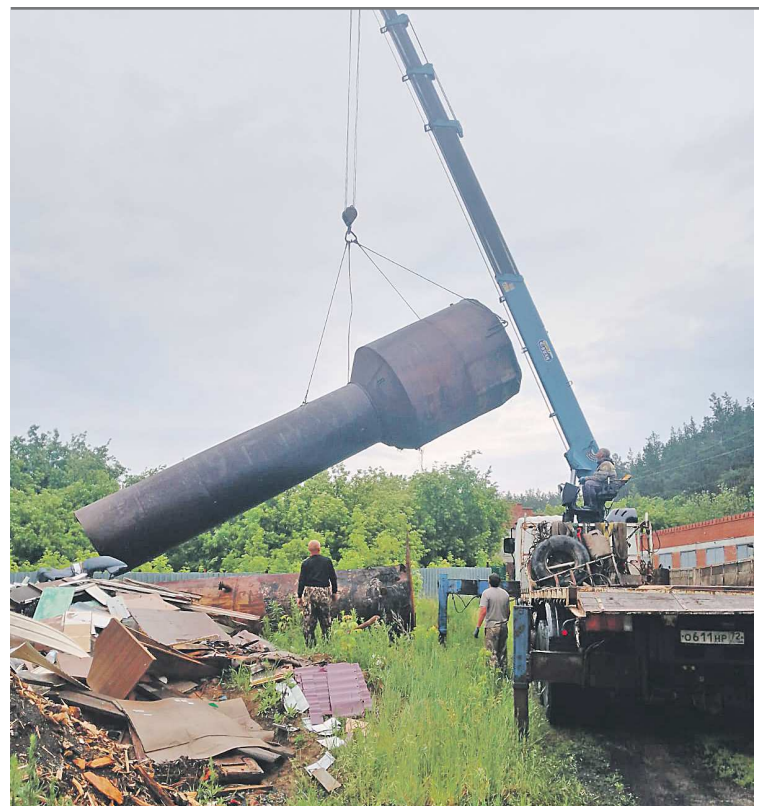
В селе Завьяловском уже провели работы по демонтажу старой водонапорной башни
