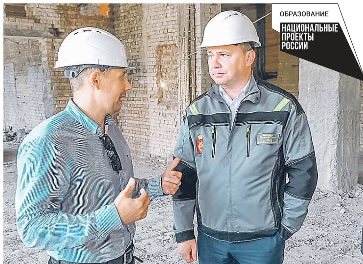
Глава Нижнего Тагила Владислав Пинаев (в центре) лично контролирует ход ремонтных работ в муниципалитете
