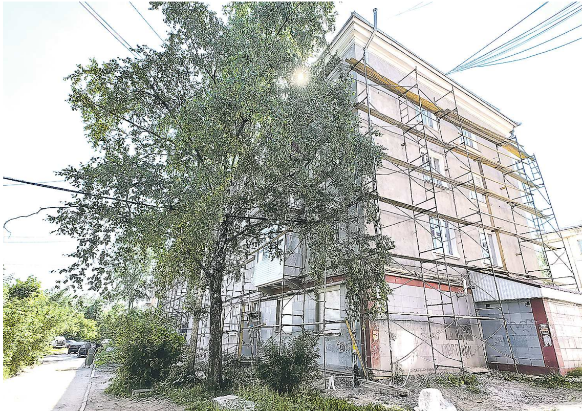
Июль, август – горячая пора капитального ремонта домов в Свердловской области
