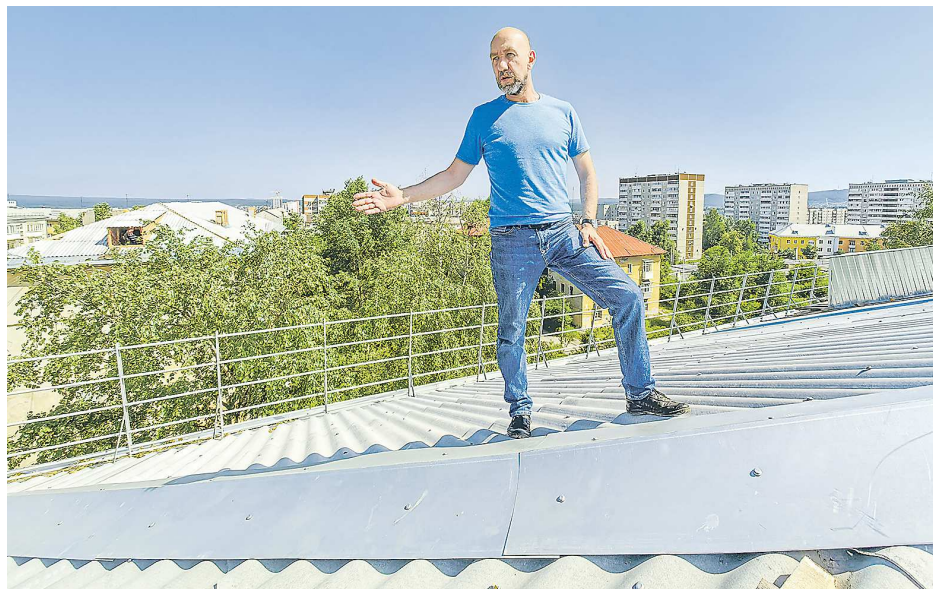
«Кровлю снимают частями, а во время дождей закрывают проемы водонепроницаемым баннером», – рассказал Александр Горнаков
