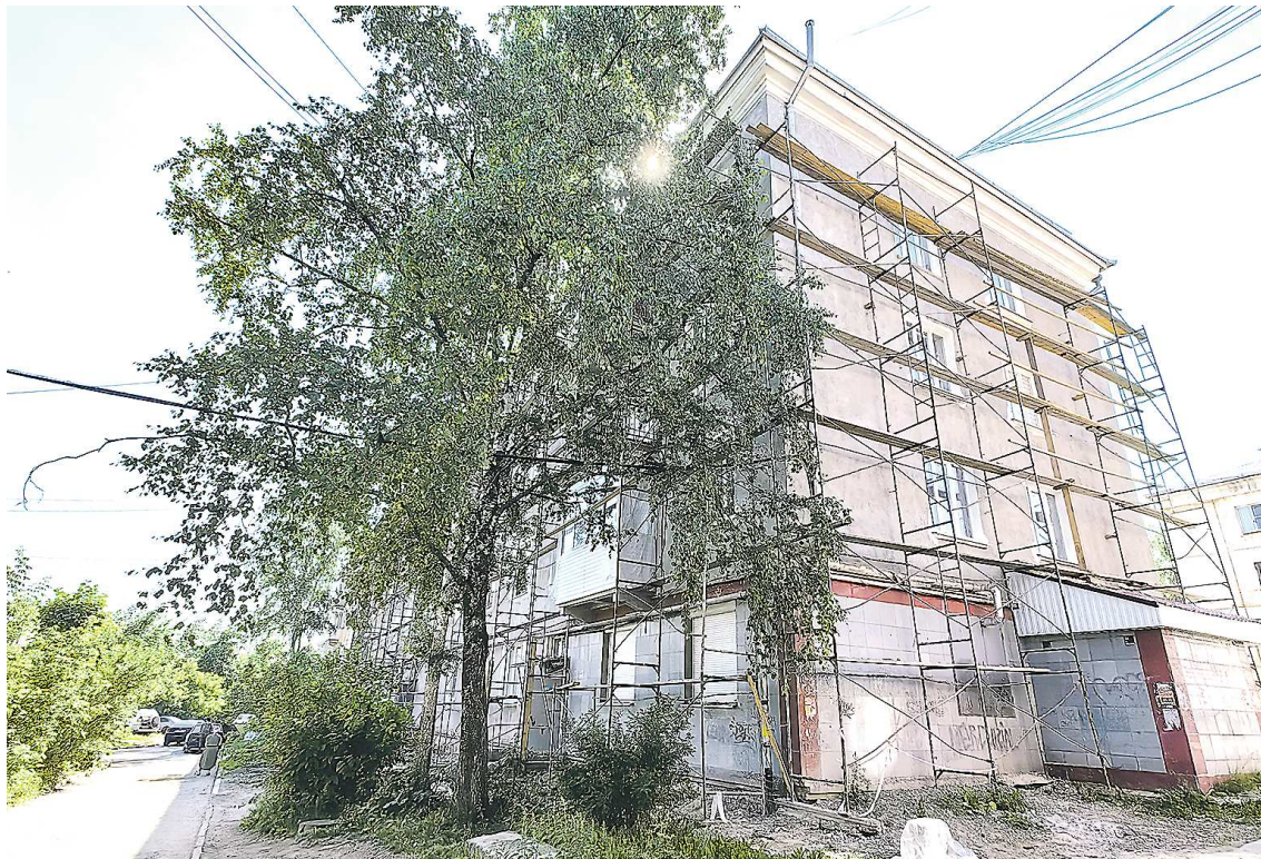
Июль, август – «горячая» пора капитального ремонта домов в Свердловской области
