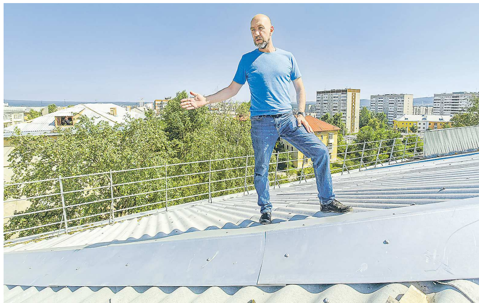
«Кровлю снимают частями, а во время дождей закрывают проемы водонепроницаемым баннером», – рассказал Александр Горнаков
