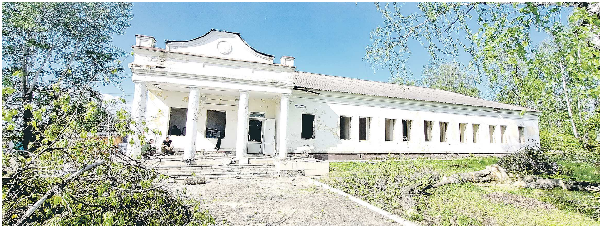
После капитального ремонта и переоборудования в старом здании администрации расположится центр молодежных инициатив
