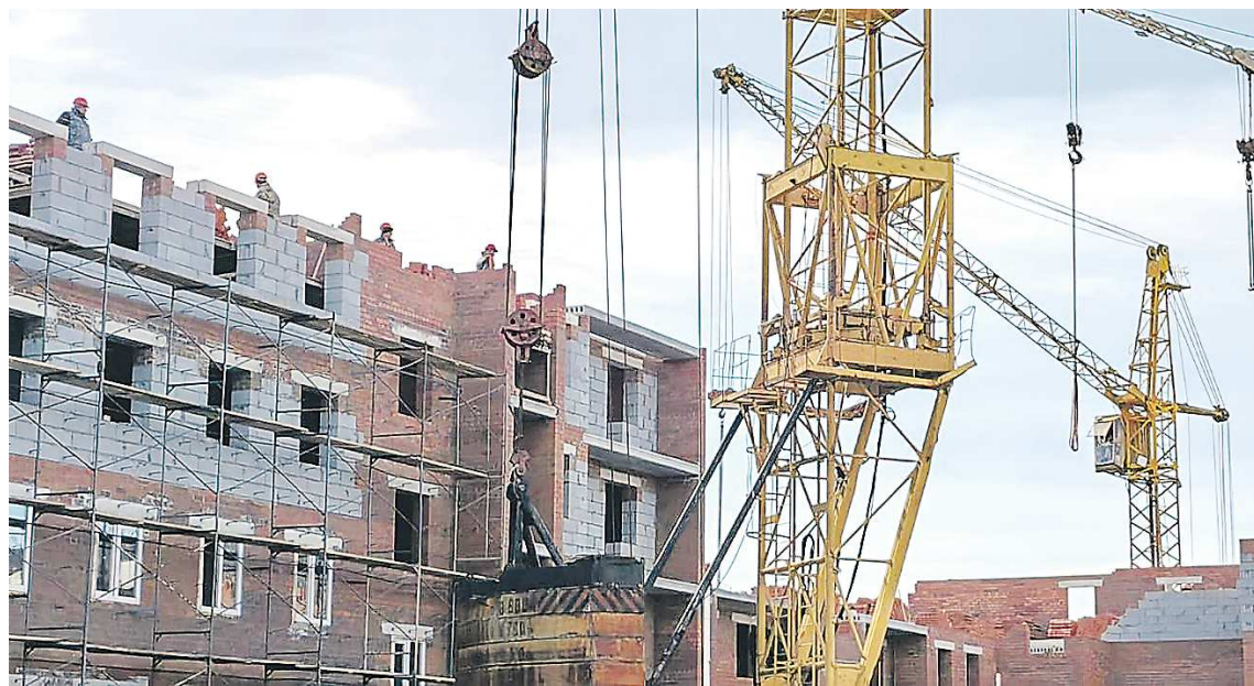
Подрядчик уже завершает строительство 3-4 этажей в многоквартирном доме по улице Ленина
