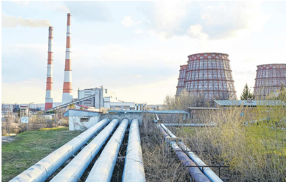
В муниципалитетах до 16 сентября предстоит обеспечить проведение модернизации коммунальных объектов и замену ветхих сетей
