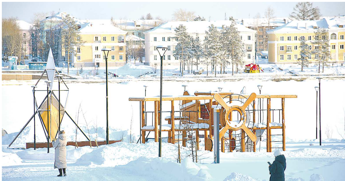
В Краснотурьинске завершена многоэтапная реконструкция набережной реки Турья
