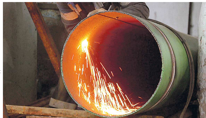
Работами по обеспечению жителей качественной водой в городском округе занялись еще летом
