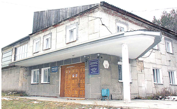
Летом 2023 года в спортивном зале школы «Олимп» проходил внутренний ремонт, теперь обновят и внешний облик здания
