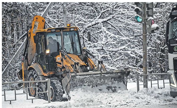
В период снегопадов дорожники работают в круглосуточном режиме
