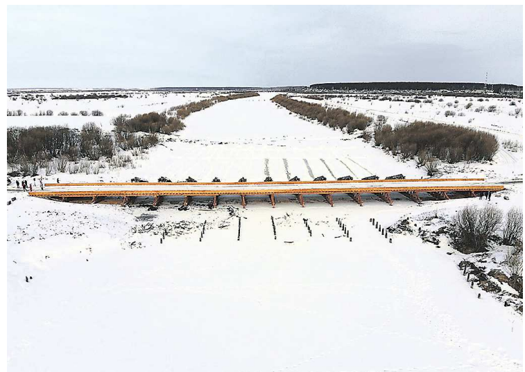
Так выглядит новый 109-метровый мост между Бобровским и Ницинским, построенный меньше чем за год
