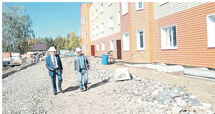
Глава Новой Ляли Сергей Бондаренко (слева) с подрядчиком осматривает новый дом
