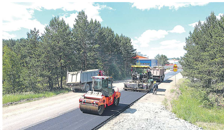
Завершается ремонт автодороги Арамилы – Фомино
