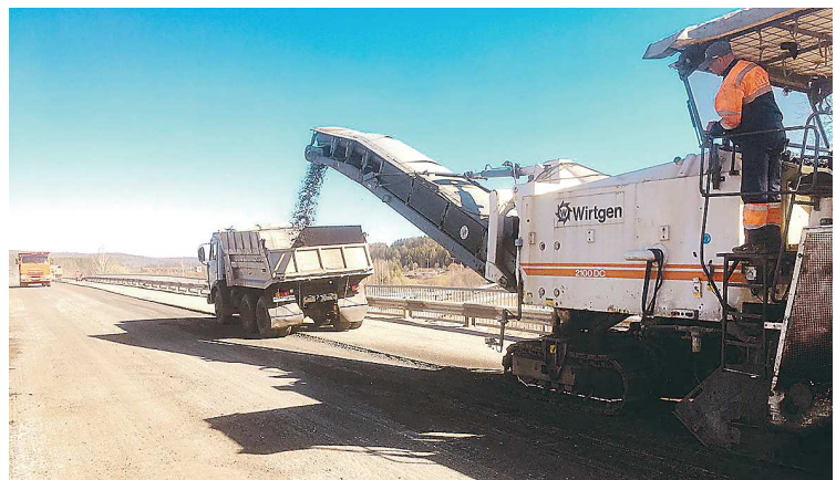
Ремонт автодороги Нижняя Тура – Качканар
