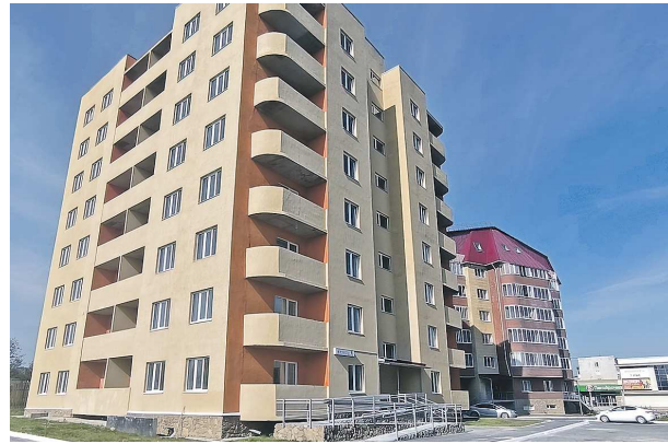
На строительство одного дома под ключ уходит чуть больше года
