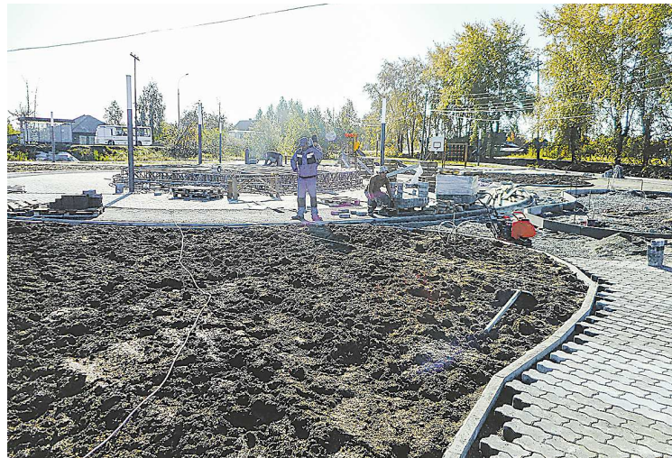
Строители подводят сети к сцене в центре новой площадки
