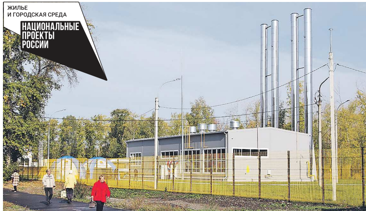
Новая газовая водогрейная котельная в Каменске-Уральском может обеспечить теплом целый поселок
