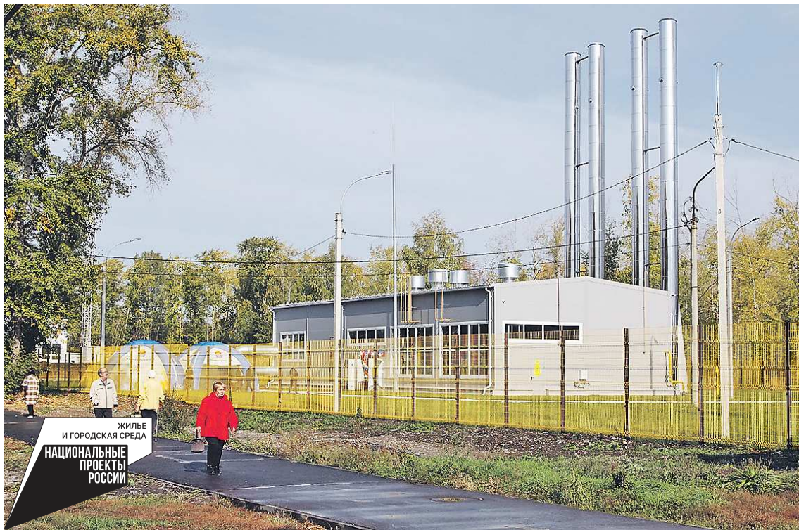
Новая газовая водогрейная котельная в Каменске-Уральском может обеспечить теплом целый поселок
