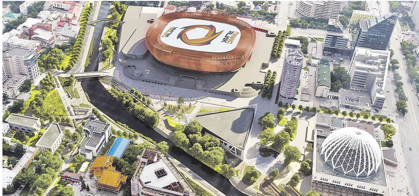
Ледовая арена с высоты птичьего полета. Пешеходный мост, который предстоит построить – слева от нее
