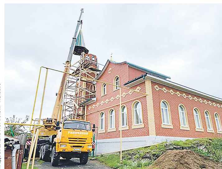
Сводчатую треугольную крышу минарета устанавливали краном
