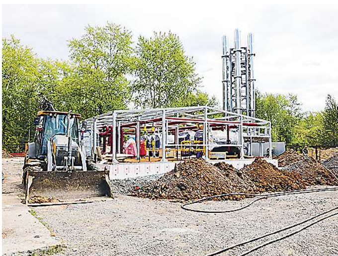
Газовые котельные перестраивают практически с нуля
