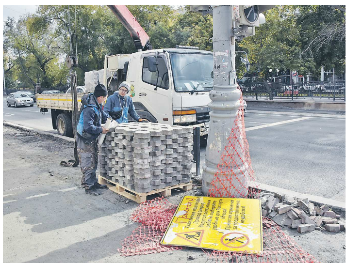
Укладку дорожной плитки возле школы подрядчик должен завершить к первому сентября
