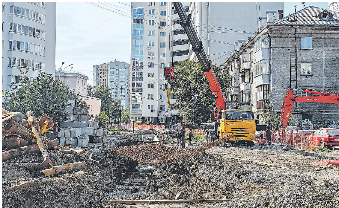
Большинство коммунальных сетей в муниципалитетах были проложены 40–50 лет назад. Их комплексная замена позволит избежать аварий и утечек тепла
