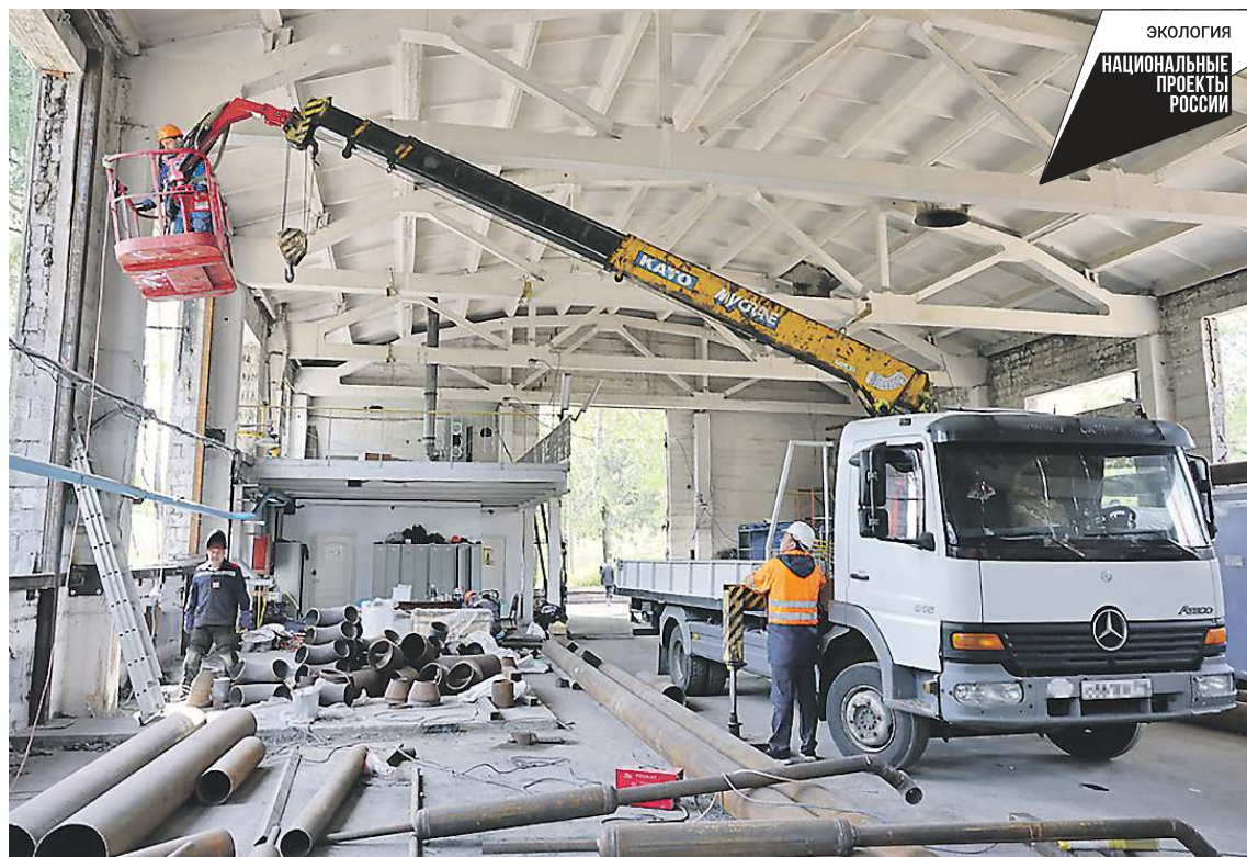
В помещениях котельных кипит работа, строители меняют практически всё
