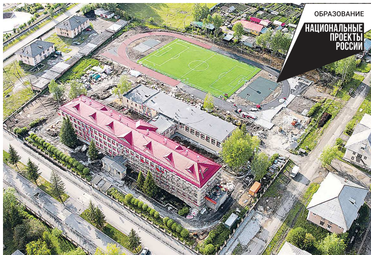
У главного корпуса школы появилась ярко-розовая кровля, хорошо заметная с высоты птичьего полета
