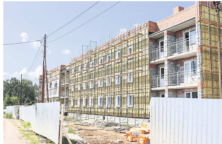
Фасад нового многоквартирного дома в Сосье сейчас утепляют
