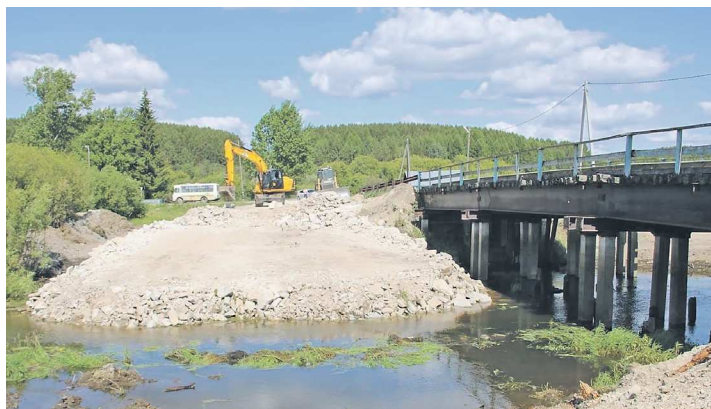
Строительная техника делает насыпь у реки рядом со старым аварийным мостом
