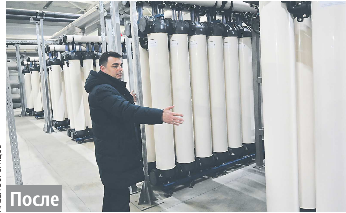
Артур Гузаиров показывает установки с мембранными фильтрами на новой станции
