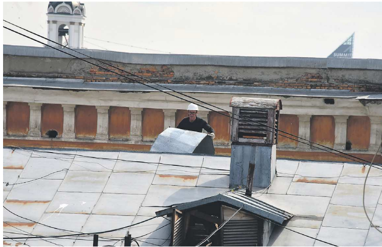
На ул. 8 Марта, 2 завершают ремонт кровли
