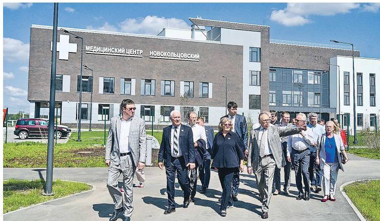
Возведением объектов кампуса занимается группа «Синара», её президент Михаил Ходоровский провел экскурсию для депутатов
