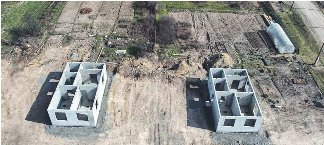
Дома возводят из готовых железобетонных конструкций, что позволяет строить коробки за считанные дни
