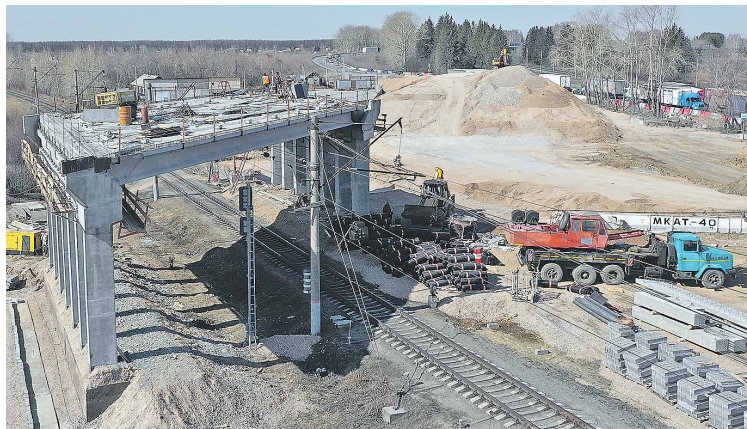
Строительство путепровода на въезде в город – один из крупнейших инфраструктурных проектов Богдановича сегодня
