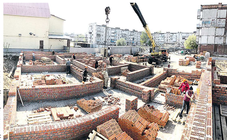
Работы идут в соответствии с графиком. Каждую неделю стройку инспектирует глава района Валентин Мионов
