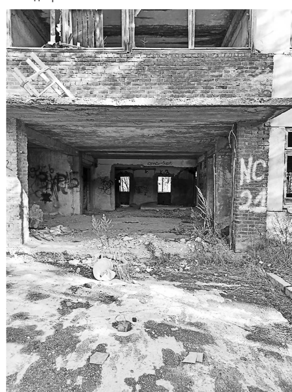
Фото 3. Зброшений цех, г. Краснотурьинск, ул. Фрунзе, 92
