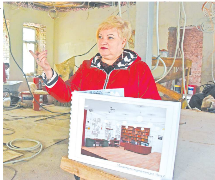
Наталья Якимова показывает, какими будут внутренние помещения Дома Окуджавы после капремонта
