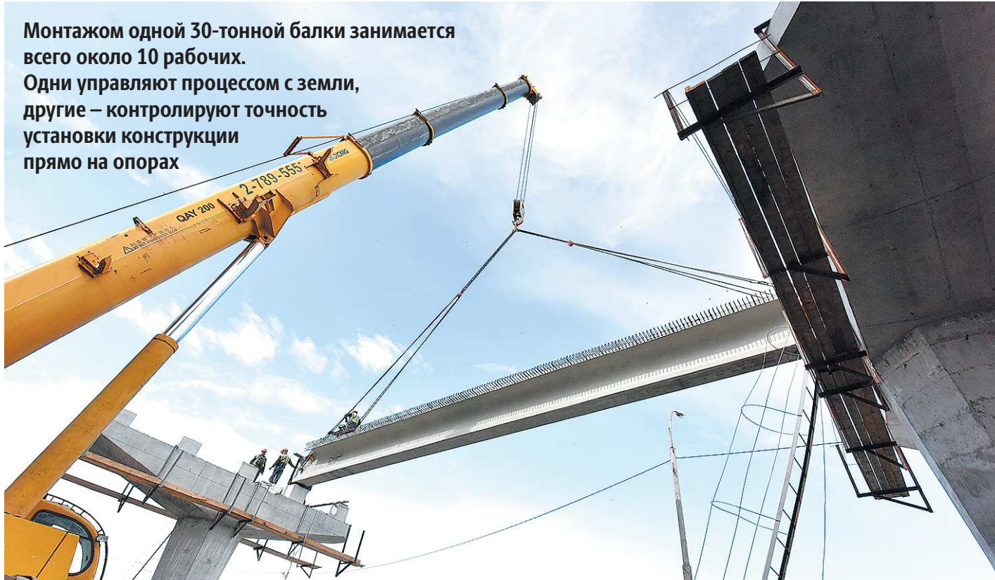
Монтажом одной 30-тонной балки занимается всего около 10 рабочих. Одни управляют процессом с земли, другие – контролируют точность установки конструкции прямо на опорах Сейчас в Свердловской области в рамках нацпроекта «Безопасные качественные дороги» реализуется еще один крупный транспортный проект – идет реконструкция и строительство Екатеринбургской кольцевой автодороги. Уже в конце этого года будет сдан последний участок, связывающий Полевской тракт с Челябинским, и по кольцу вокруг уральской столицы запустят движение транспорта. Изначально это планировалось сделать в 2023 году, но Президент РФ Владимир Путин поручил выделить дополнительные средства из федерального бюджета. Общая стоимость контракта составляет 8,4 млрд рублей.
