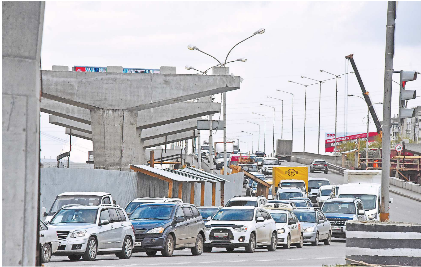
Уже на днях рабочие начнут укладывать пролетные балки на путепроводе у концерна «Калина»
