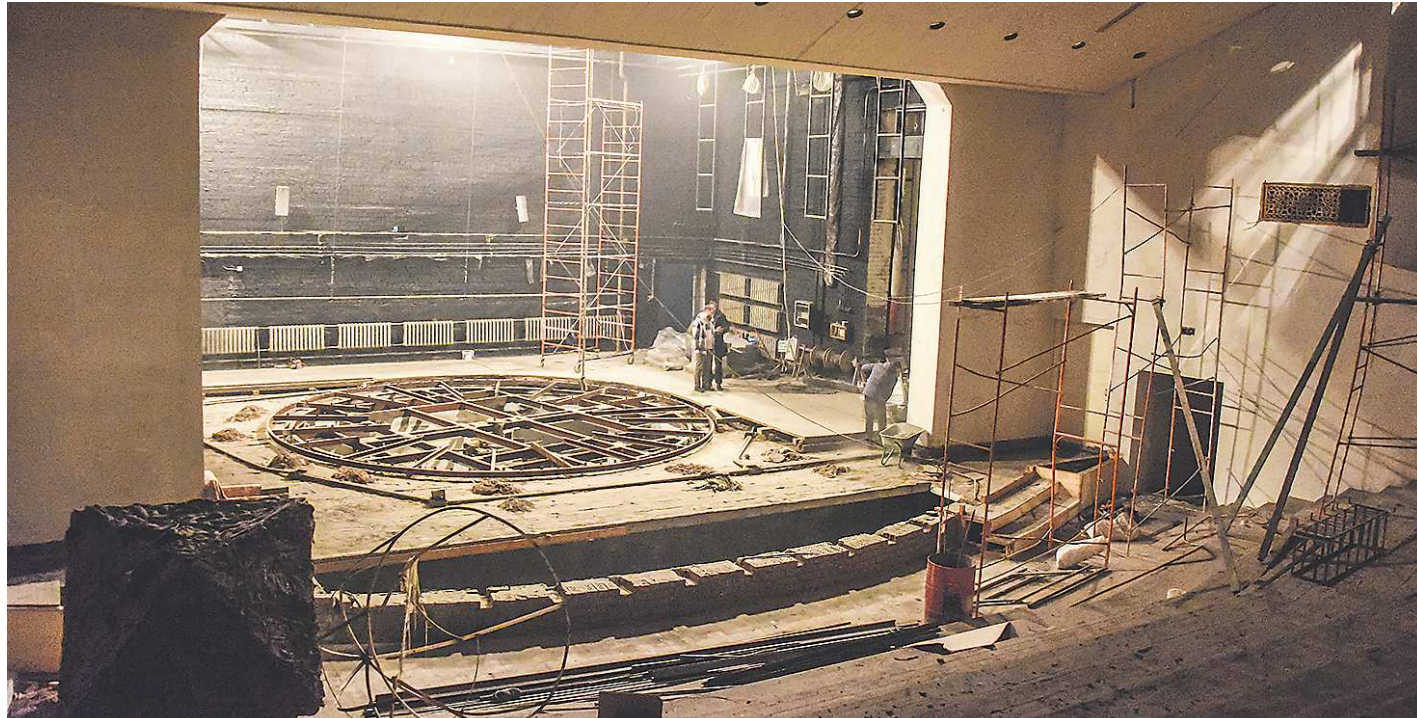
Ремонт зрительного зала во Дворце детского и юношеского творчества: строители меняют полы, кресла, сценическое покрытие, конструкцию поворотной сцены. На оборудование потрачено 25 млн рублей, вместимость зала – 450 человек
