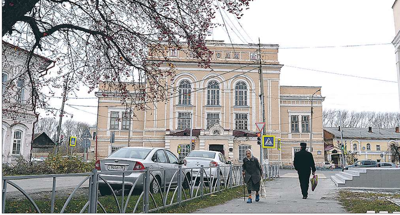
Масштабных реставрационных работ в ирбитском Пассаже не было с момента открытия в 1864 году
