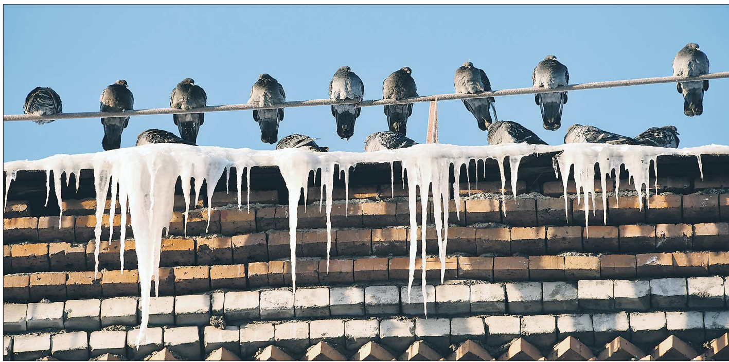
Постановление Госстроя №170 предписывает производить очистку крыш от наледи по мере её возникновения
