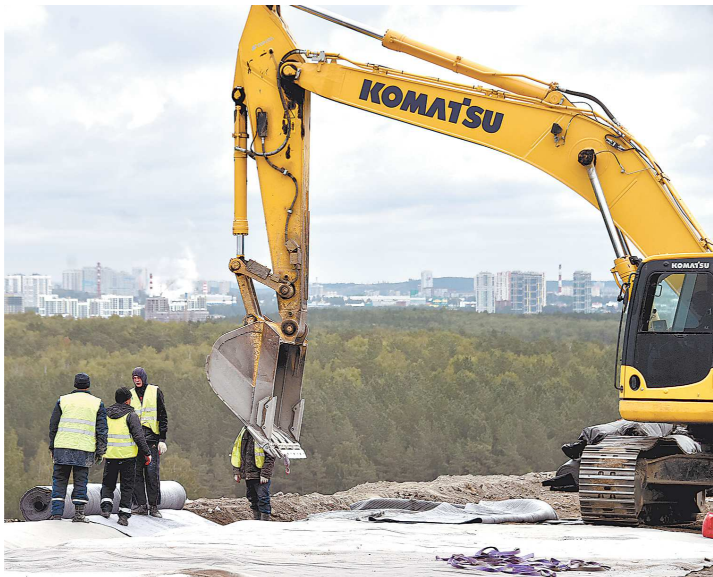
Рабочие укладывают геотекстиль, который служит для укрепления склонов и отвода воды
