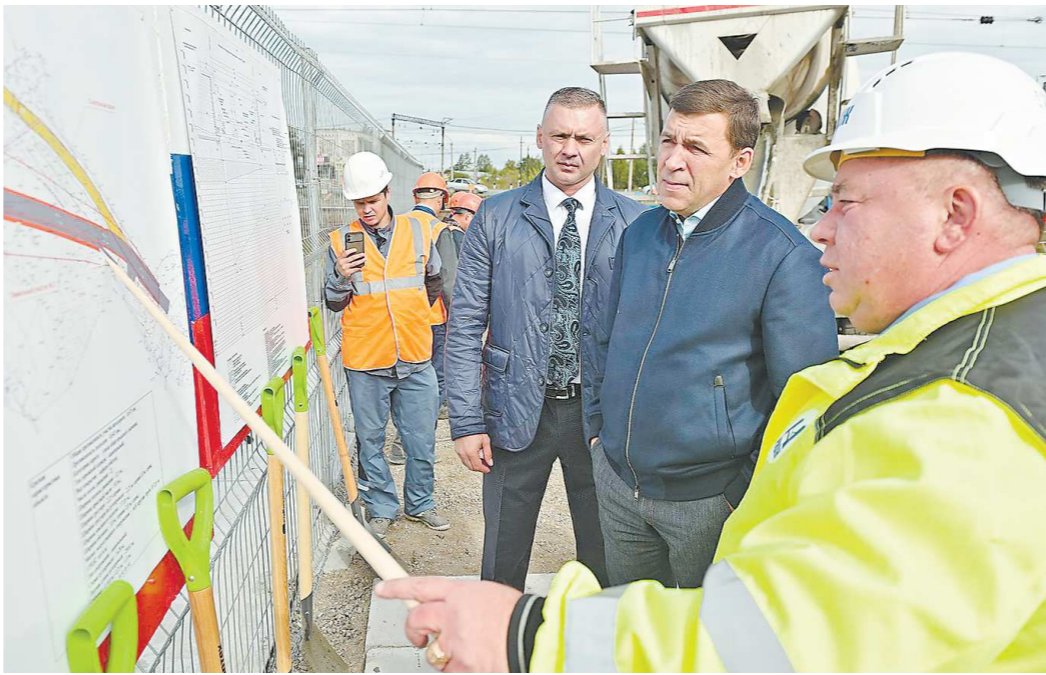
Владислав Новиков (справа) рассказал Евгению Куйвашеву, что мост будет однопролетным и стоять будет на буронабивных сваях
