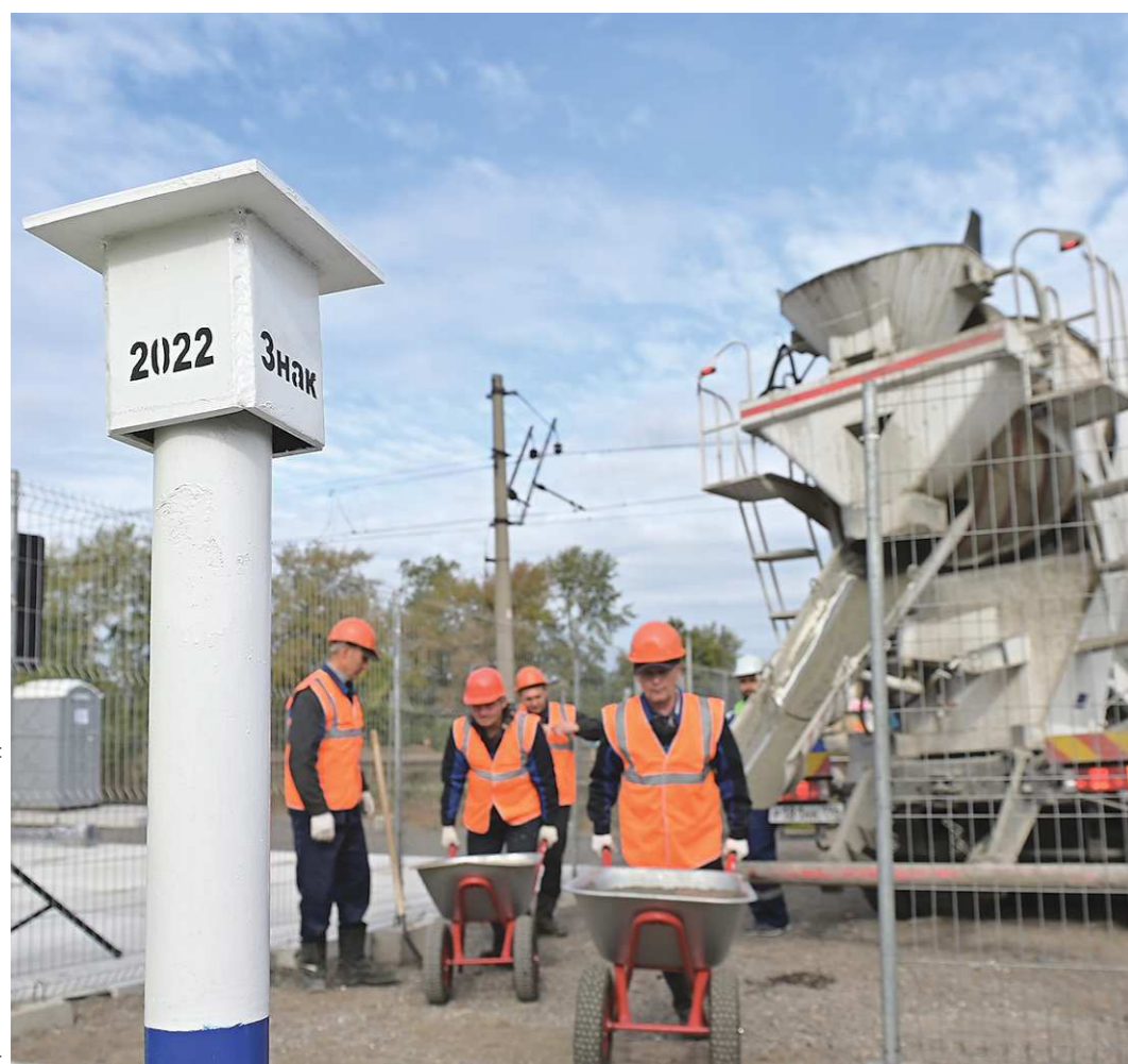
Строители везут бетон к первой геодезической точке, откуда начнется возведение моста
